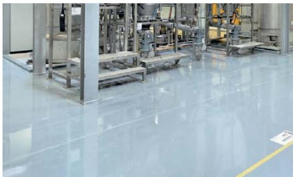
Para requisitos especiales, se combinan diferentes sistemas de aglutinante y relleno para lograr propiedades específicas, por ejemplo, poliuretano y cemento en la gama *Sikafloor® PurCem®* para altas temperaturas y resistencia química en ambientes húmedos.
