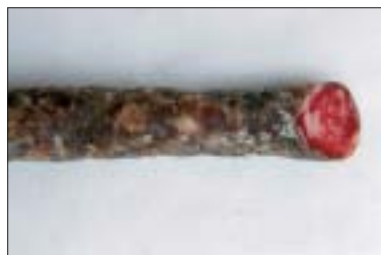
Figura 4a. Oxidación superficial.
